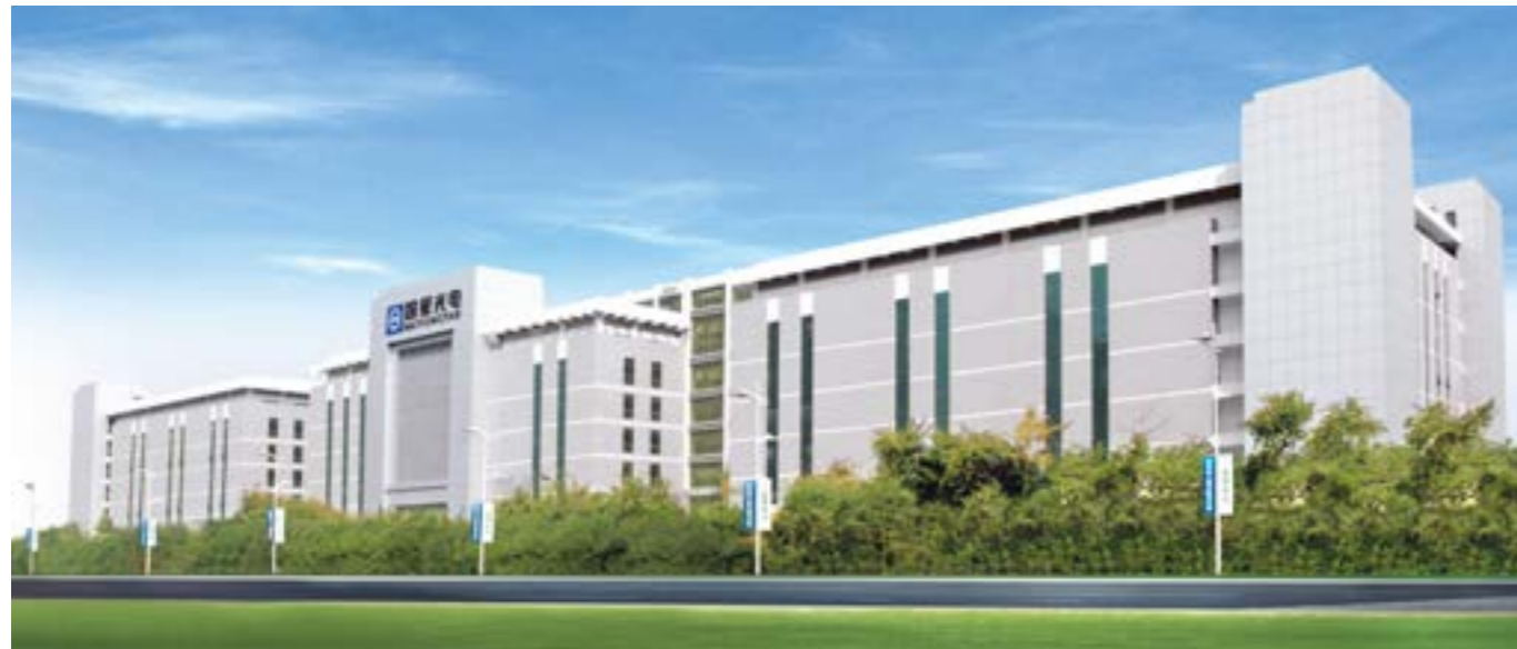
国星光电总部 佛山华宝厂区 公司总部，LED器件、LED组件生产基地 占地面积：60,600平方米 建筑面积：139,000平方米
