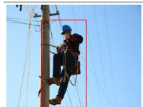
安防措 施检测
